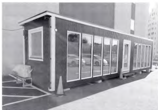
院外駐車場に設置されたプレハブ
